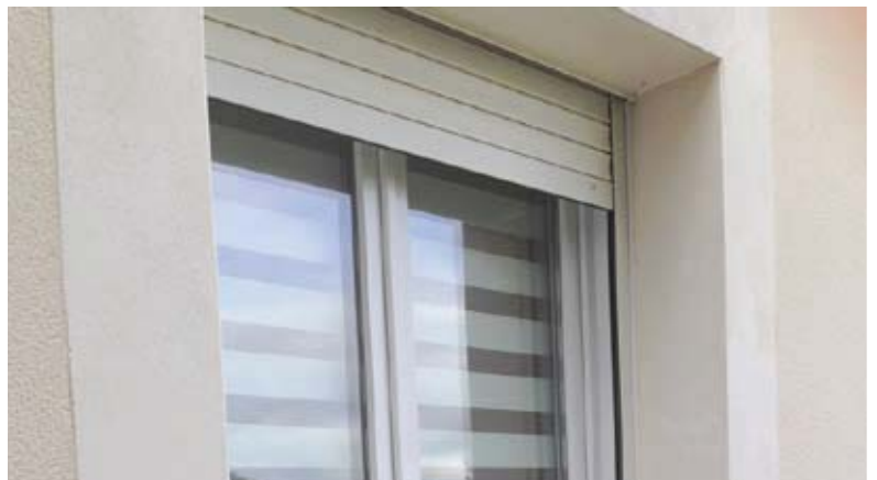
Type B : pose en tableau intérieur
